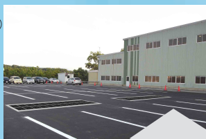
駐車場に設置
