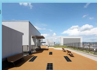
ビルの屋上に設置
